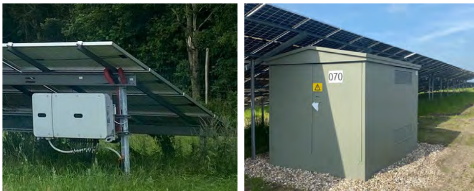
Figur 1-6 Eksempel på inverter (t.v.) og transformer (t.h.).
