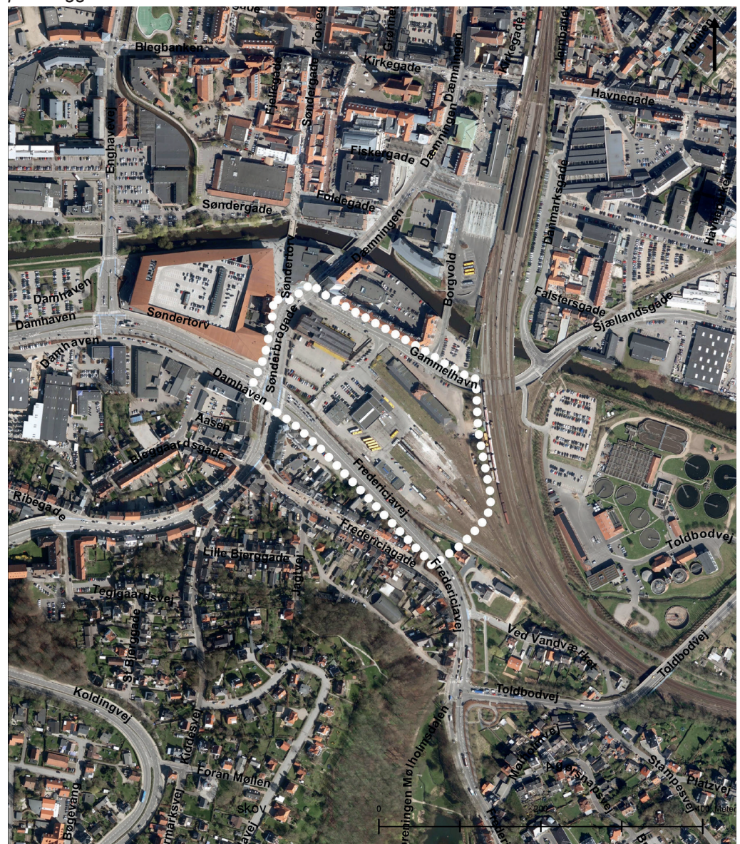
Figur 4.1. Luftfoto af den del af projektområdet, hvor bebyggelsen og den nye vej planlægges etableret
