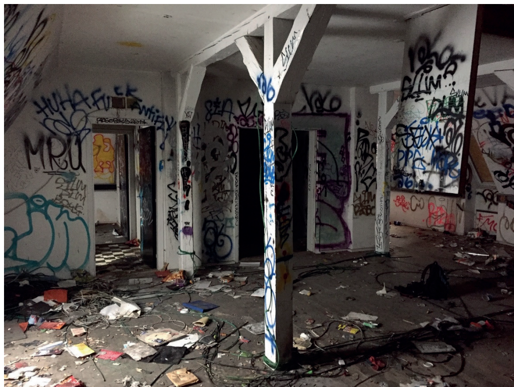
Figur 17.2. Billede fra bygningsgennemgangen 10 marts 2020.
