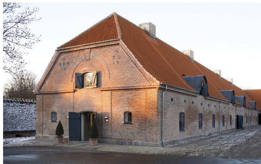
Renoveret staldbygning - Hindsgavl Slot
